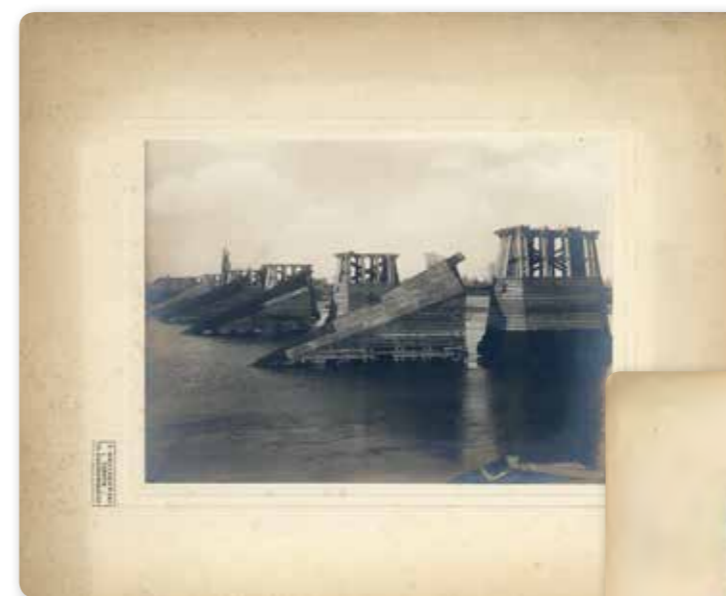
Budowa mostu drewnianego na Wiśle pod Szczucinem, 1924 r., T. Mroczkowski, AP Kielce, sygn. 21/100/18972.
