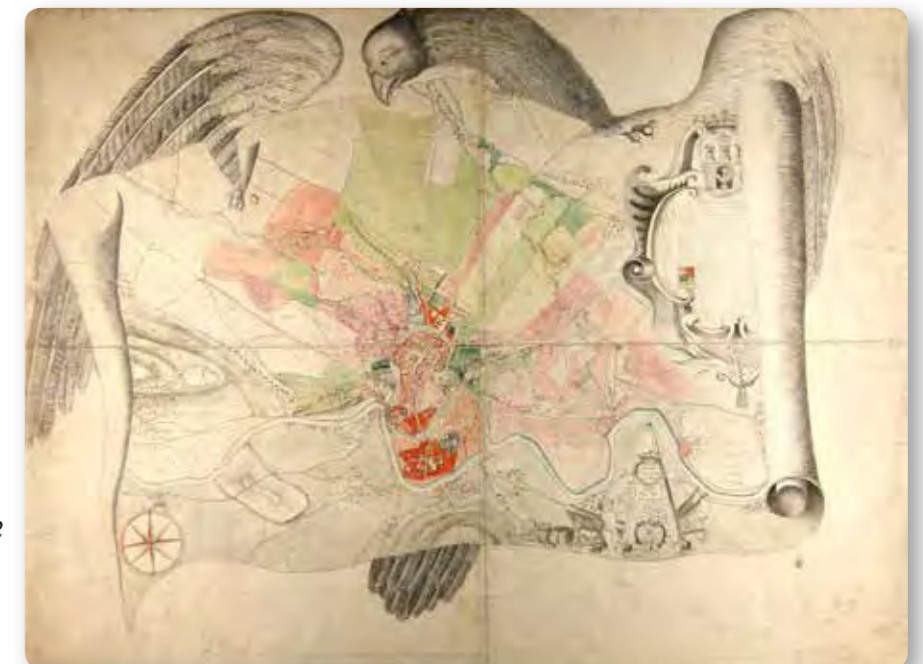
Wymiar geometryczny miasta Krakowa z przyległymi terenami, 1792 r., AN Kraków, sygn. 29/663/85. Geometric dimension of the city of Kraków with adjacent areas, 1792, AN Kraków, sig. 29/663/85.
