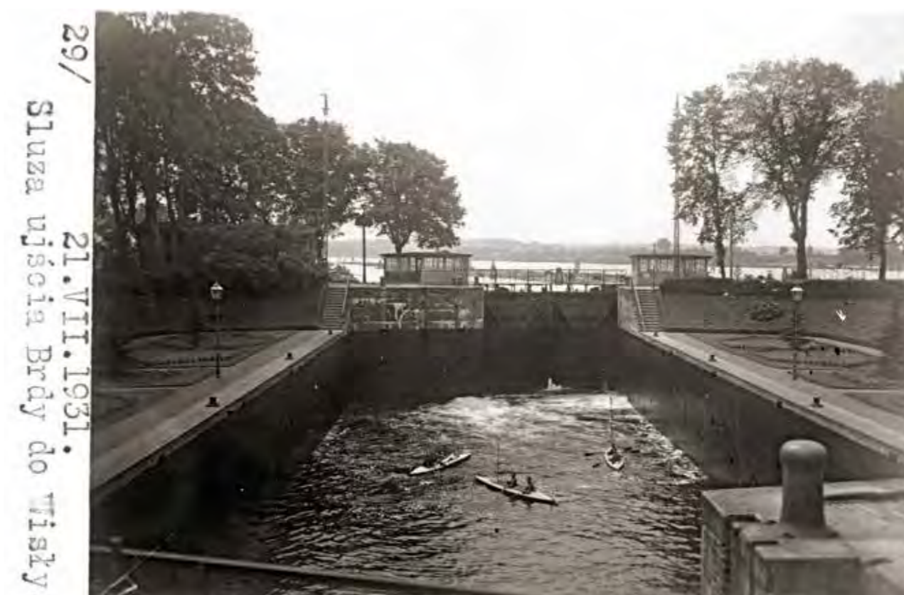
Sluza przy ujściu Brdy do Wisły, Bydgoszcz-Brdyujście, 21 lipca 1931 r., AP Bydgoszcz, sygn. 6/2233/1448. Floodgate at the estuary of the Brda River to the Vistula, Bydgoszcz-Brdyujście, July 21, 1931, AP Bydgoszcz, sig. 6/2233/1448.
