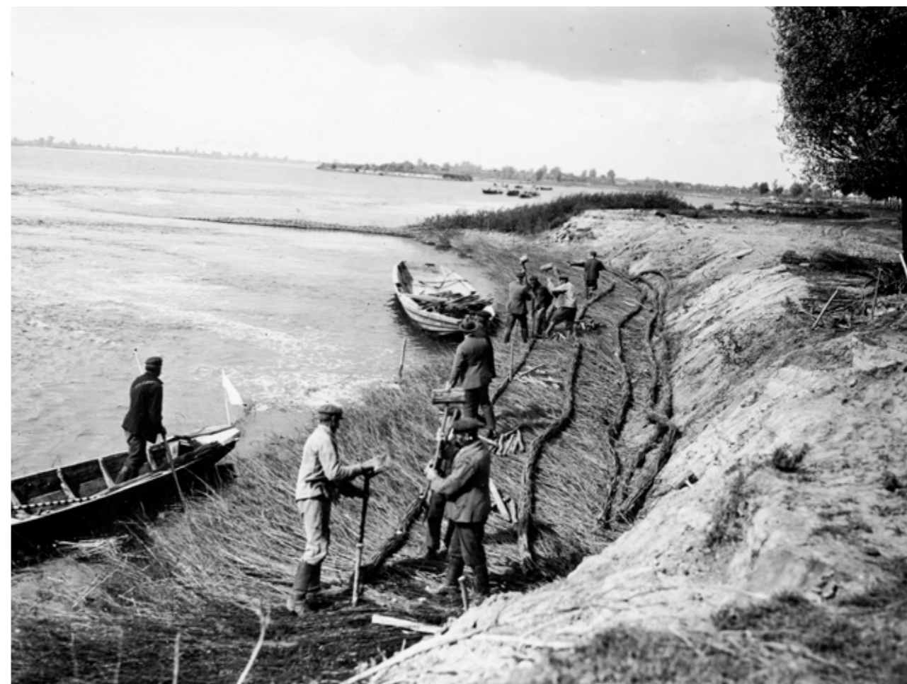
Robotnicy przy umacnianiu faszyną brzegów Wisły pod Warszawą, czerwiec 1927 r., NAC, sygn. 3/1/G/4569. Workers at strengthening banks of the Vistula near Warsaw by fascine, June 1927, NAC, sig. 3/1/G/4569.
