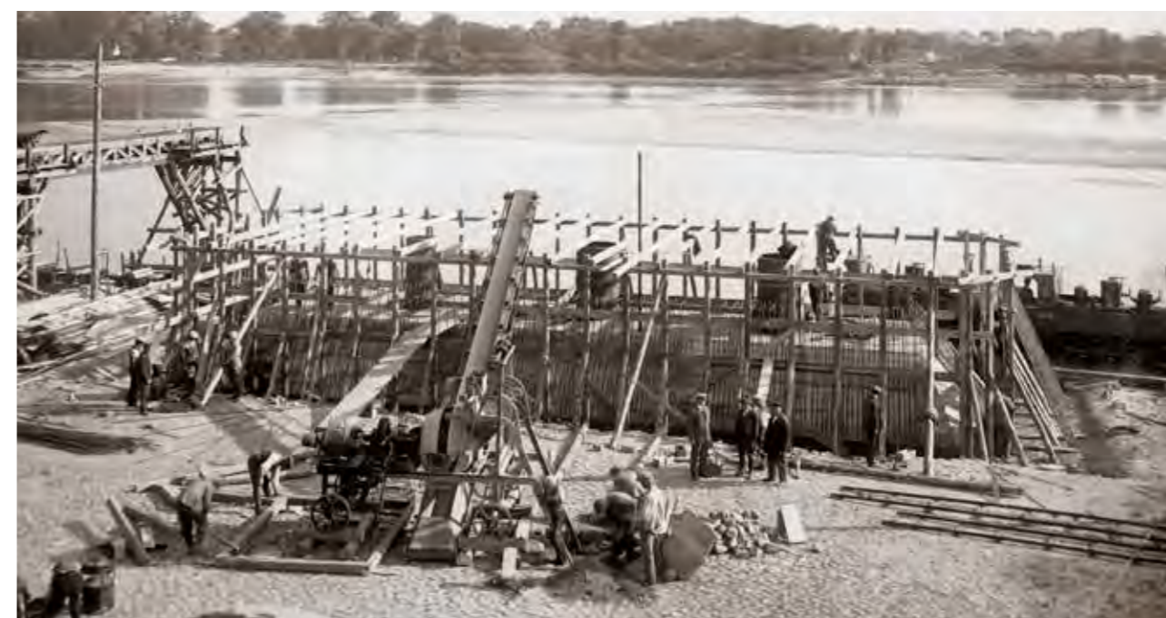
Budowa pierwszego mostu drogowego na Wiśle w Toruniu, początek lat 30. XX w., NAC, sygn. 3/1/G/3484. Construction of the first road bridge over the Vistula in Toruń, the beginning of the 30s of the XX century, NAC, sig. 3/1/G/3484.
