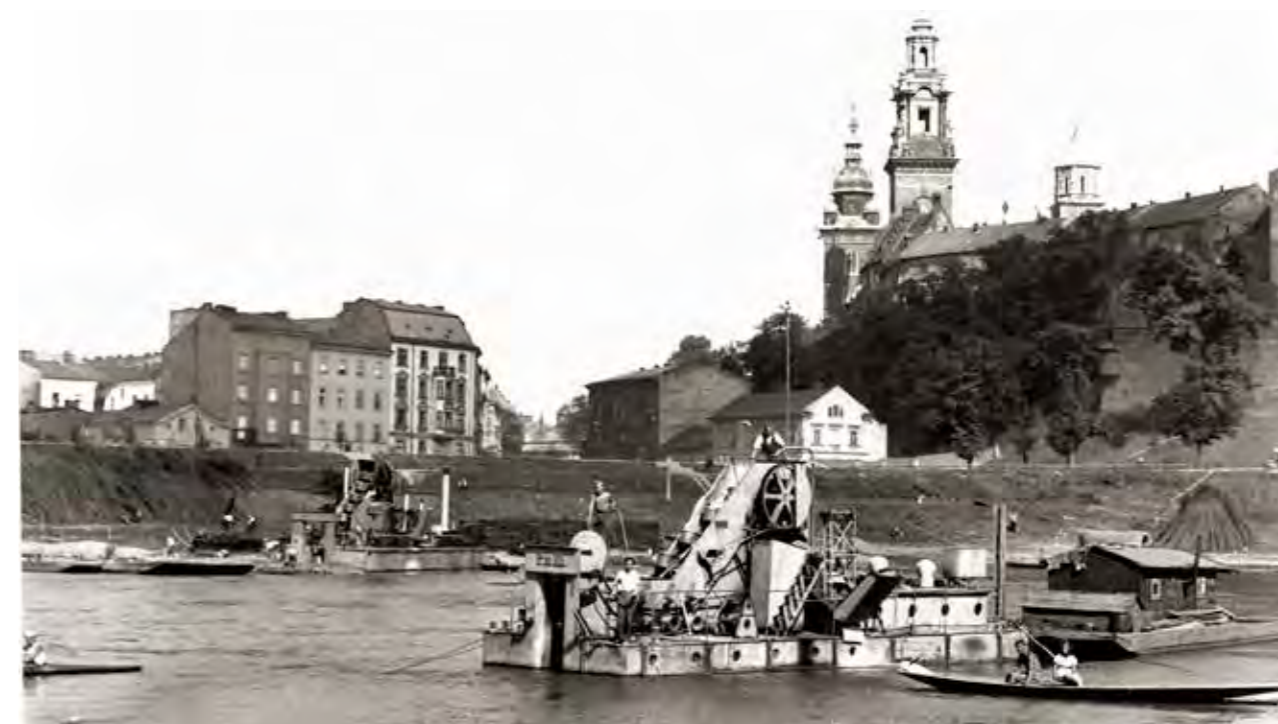
Regulacja Wisły w Krakowie - częściowa zmiana koryta Wisły koło Wawelu, widoczne pogłębiarki, sierpień 1939 r., NAC, sygn. 3/1/G/4566-1.
